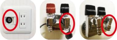
壁埋込型ガスコンセント、ヒューズガス栓(カチット用ガス栓側)があれば、ガスコードをつないで利用できます。
